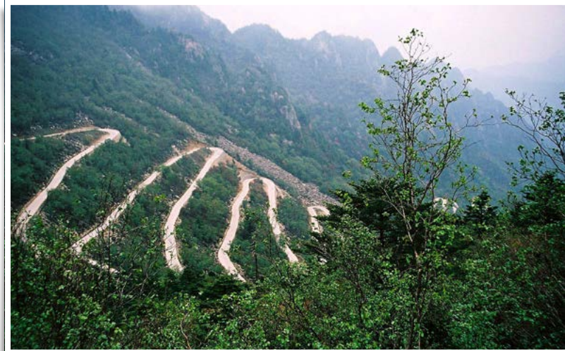
▲ Nyanlagd väg Taibai Shan 3300 m.
